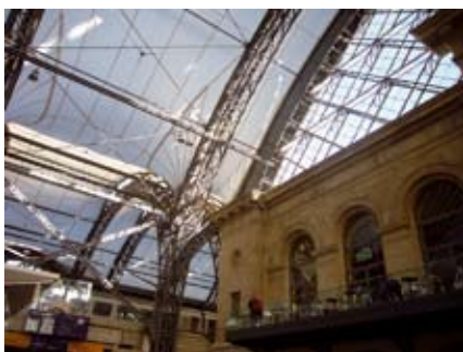
Dachkonstruktion Dresdner Bahnhof
